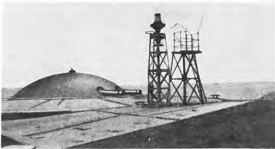
Bild 35 Panzerfort Pampus Einer der beiden 24 cm Geschützdrehtürme Gerüste für Leuchtfeuer und offene Beobachtung
