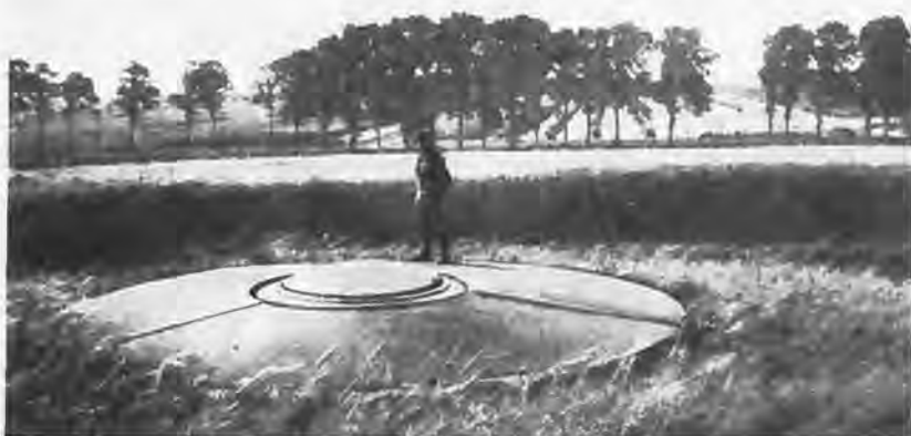
Bild 121: Ein 5,7 m Verschwindturm im Fort Hoofddorp. Erhöhungswinkel + 6^\circ , - 6^\circ . Schußweite 3500 m. Lieferwerk Krupp-Essen und Schneider-Creusot.
