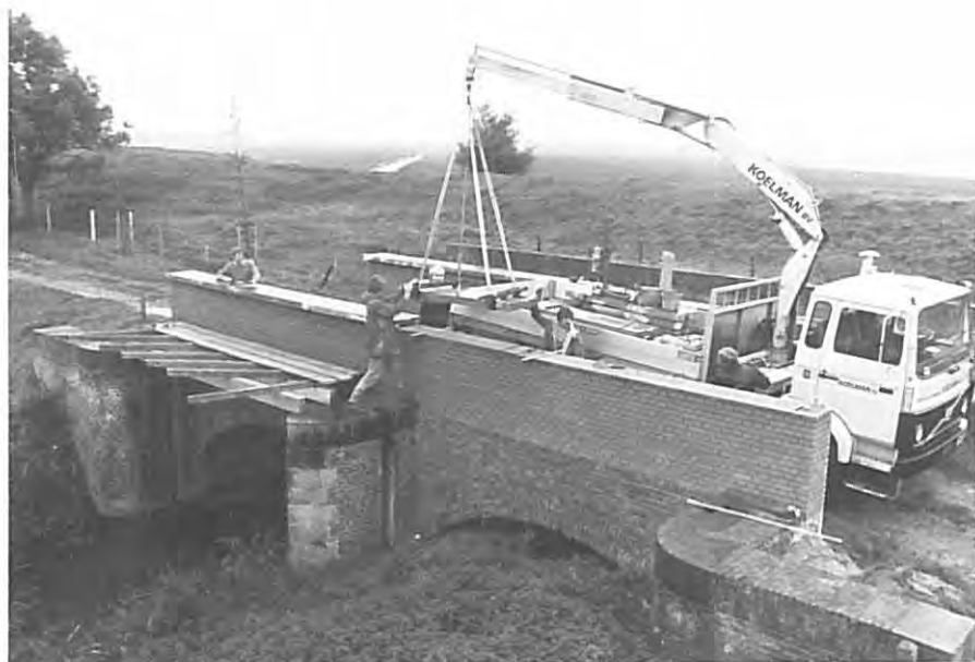
Restauratiewerk aan de Liniedijk door de Zuidwijkermeerpolder.
