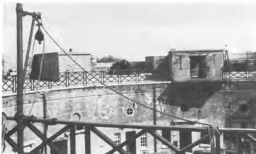
Een blik over het laaggelegen terreplein van Harwich Redoubt naar een bij de restauratie weer geplaatst stuk geschut, een getrokken voorlader met een kaliber van 22,5 cm. (foto S. H. Poppema)
