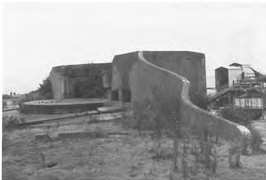
Landguard Right Battery. Emplacement met betonnen achterwand tegen luchtaanvallen in de rug. (foto S. H. Poppema)
