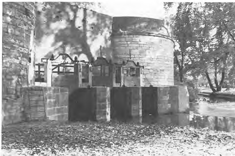
Gerestaureerde sluis voor de 'reek' (Waterpoort). (foto J. Stevens)
