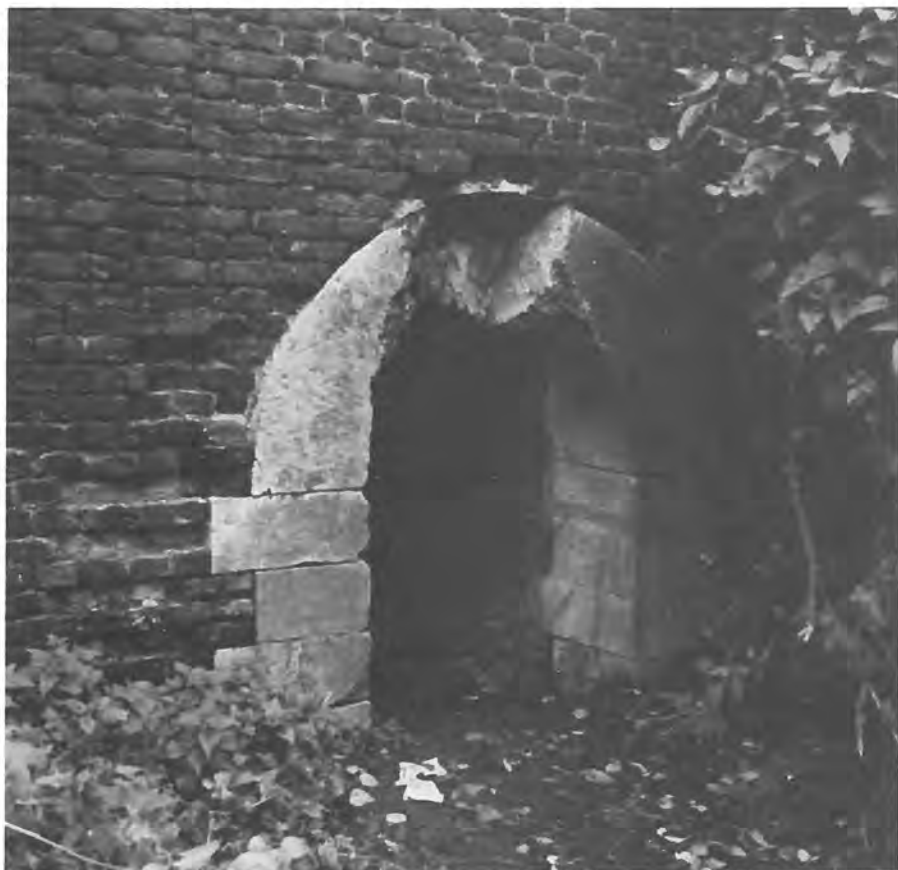
Inlaat van de duiker in het bastion B., na de ontvreemding van de sluitsteen. (Foto L. J. Morreau)
