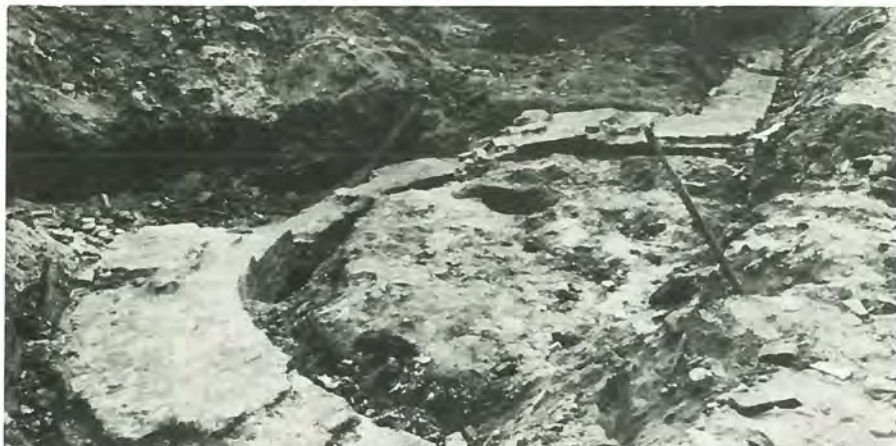
Kampen, restant fundering stadsmuur met randeel. (Foto A. J. Tempelman)
