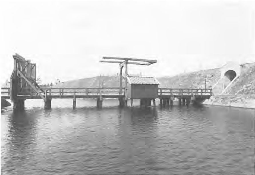
'Sekreet' aan de brug voor de Munstersepoort.
