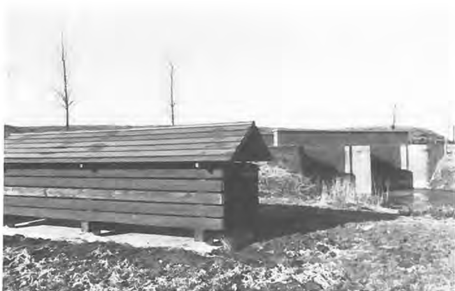
Herbouwde schotbalkenloods met de sluis op de achtergrond. (foto M. Kiel)
