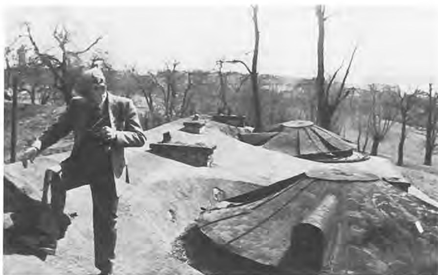
De parasolvormige afdekkingen van de pantserkoepels op het fort Skotniki, zw van Kraków, links met camera H. A. Treu. (foto M. Holewinski)
