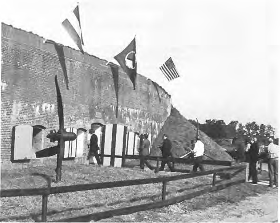
Gerestaureerde kruutkamer op de dag van de opening. (foto J. Graas)
