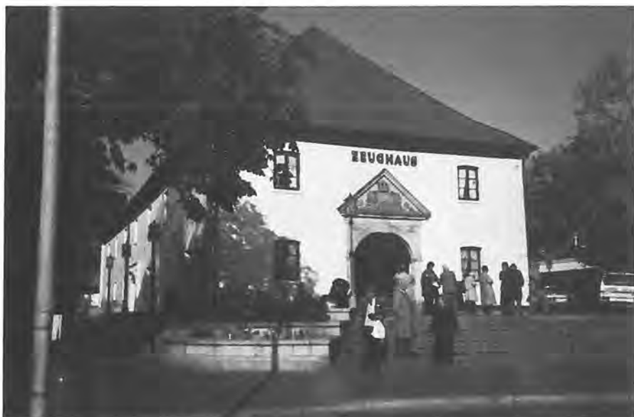
Het gerestaureerde, door de Zweden in de zeventiende eeuw gebouwde arsenaal te Stade. (foto S. H. Poppema)
