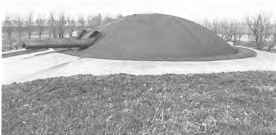
De draaibare pantserkoepel van het fort Spijkerboor met twee kanonnen 10,5 L 25, Krupp-Creusot. (foto J. de Zee)
