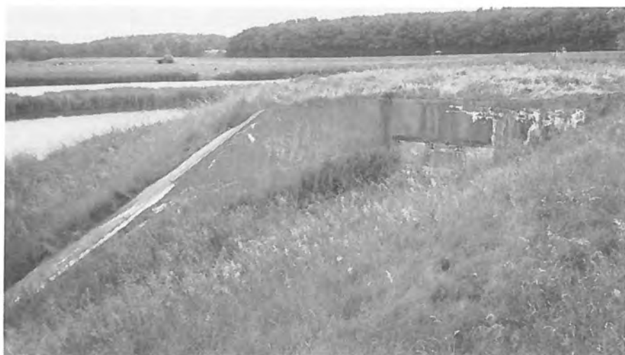
Fort aan de Sint-Aagtendijk, de frontcaponnière, zuidzijde. Foto S. H. Poppema.
