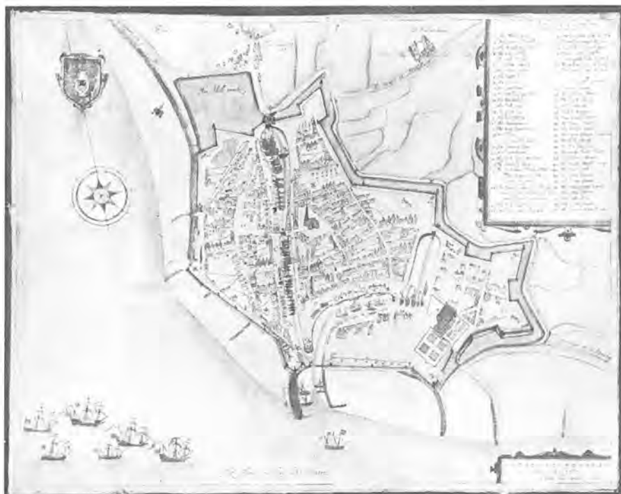
Vlissingen, 1585, door Robert Adams (Hatfield House).
