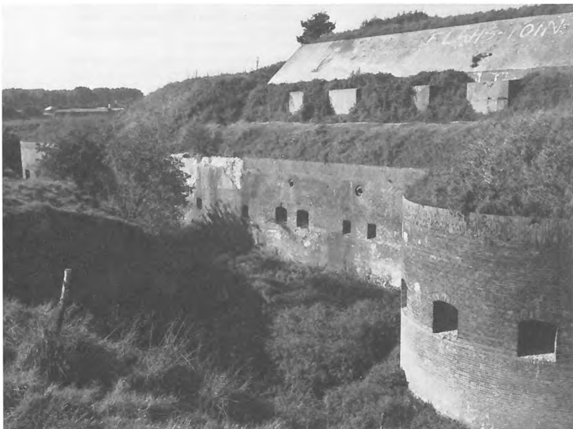
Fort bij Pannerden. Droge gracht met caponnière. Op het bovenvlak de hoofdbatterij. Foto S. H. Poppema.
