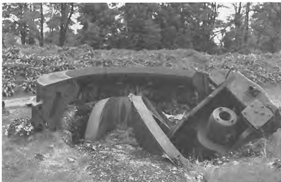
Fort Loncin. Een van de pantserkoepels die in 1914 werden vernield door de inslag van een Duitse granaat in een munitiemagazijn van het fort. Foto H. A. Treu.
