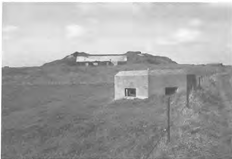
Fort bij Pannerden. Een stekelvarken in het voorveld van het fort. Op het fort de hoofdbatterij met links en rechts de nevenbatterijen. Foto S.H. Poppema
