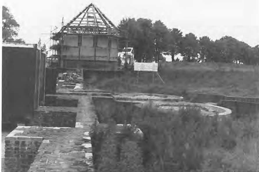
Heusden. De 'haventoren' die er volgens onze Stichting niet had mogen komen, in aanbouw. Foto H.A. Treu.
