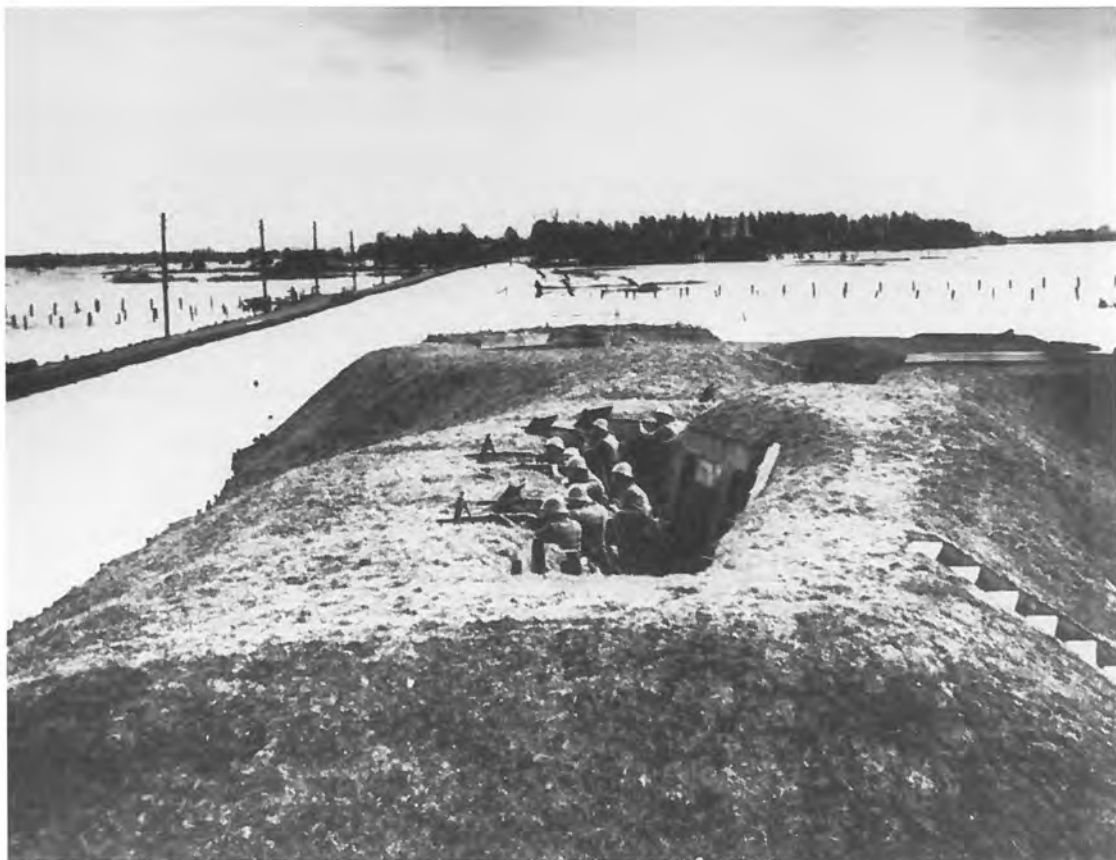
Gevechtsofstelling voor infanterie in ophoging in geïnundeerd terrein aan het Benedeneind te Veenendaal. De frontale gronddekking is zwaar, maar de opstelling is kwetsbaar voor verticaal inkomend vuur en scherfwerking (foto SMG).
