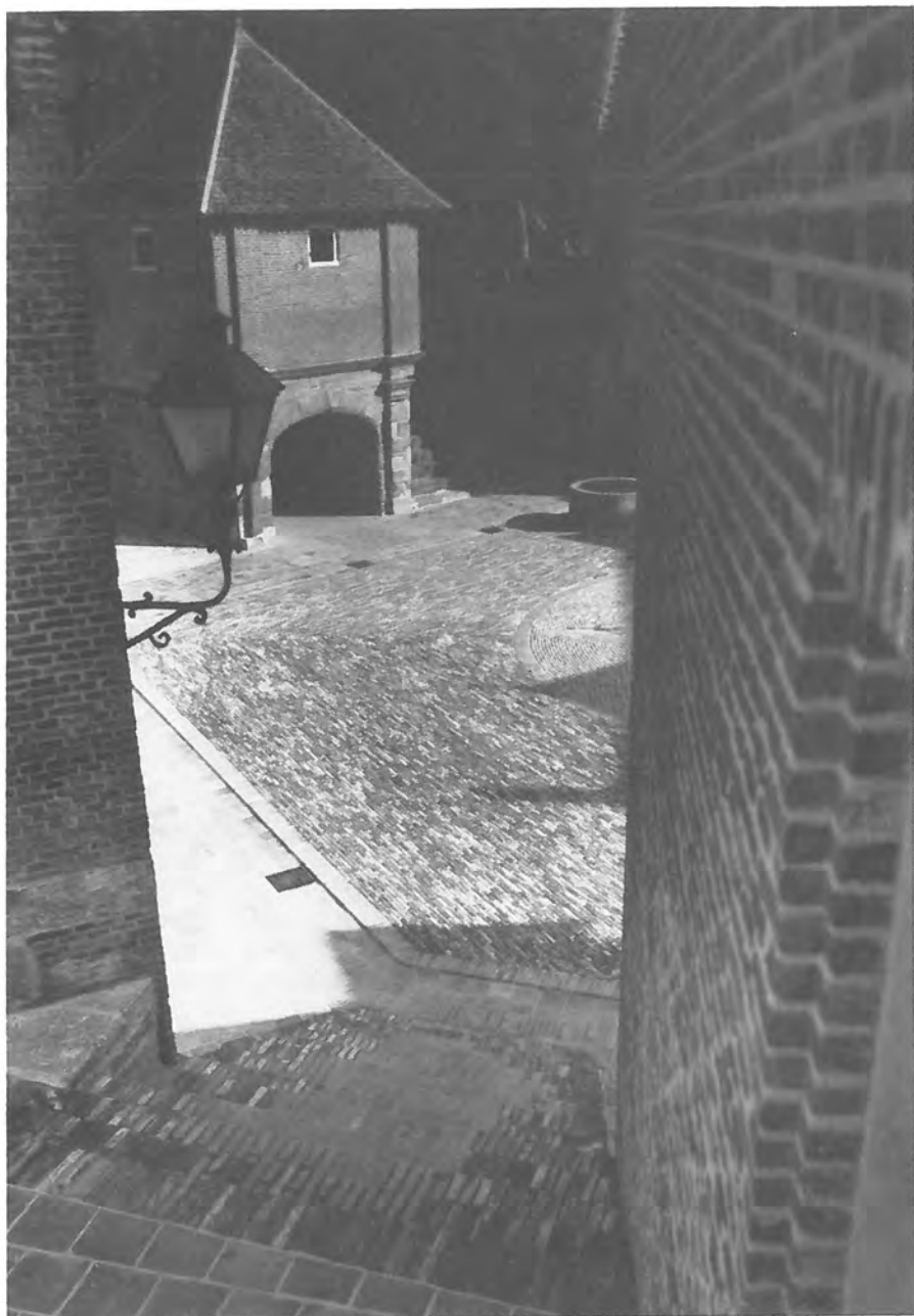
6 Suriname, Paramaribo. Fort Zeelandia, binnenplaats en poortgebouw (Prolasco, 1973).
