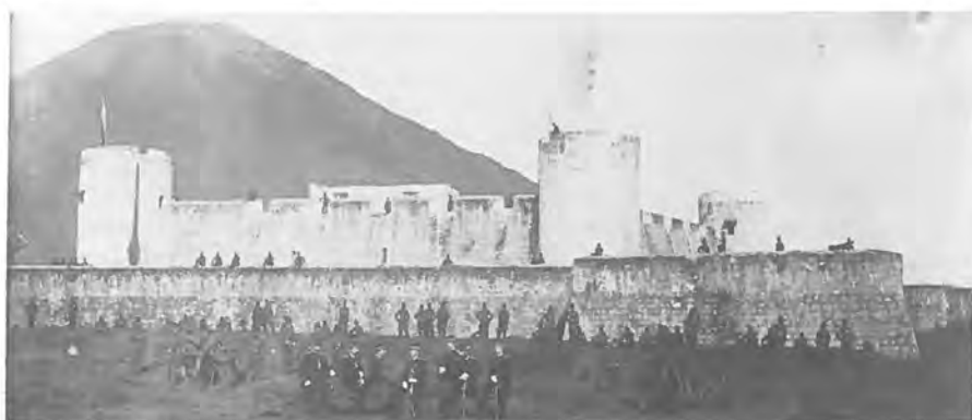
2 Indonesië, Banda-archipel, Neira. Kasteel Belgica met de rondelen, toestand omstreeks 1900 (Rijksdienst voor de Monumentenzorg).
