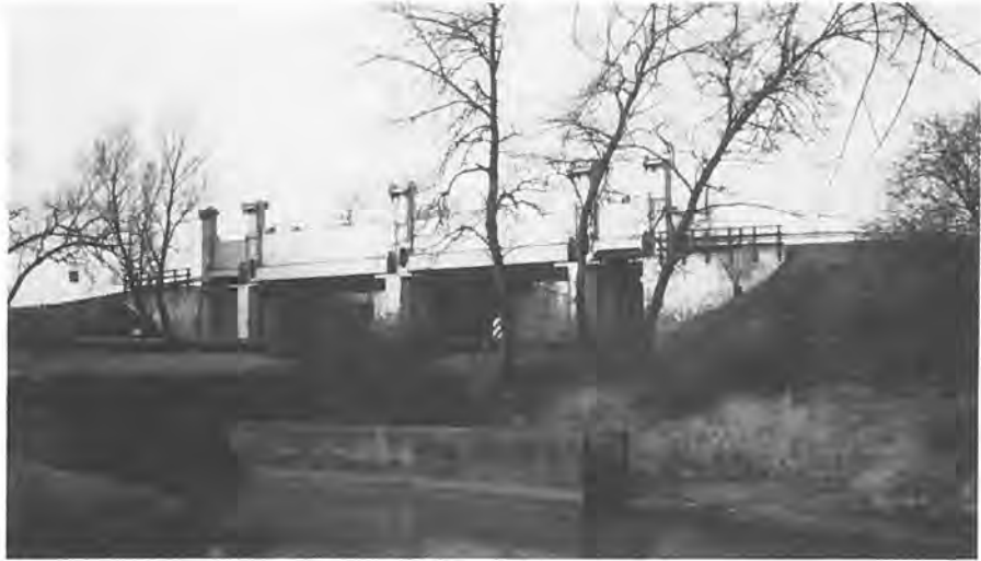
Waterkering met schuiven in de Diefdijk op de plaats waar de A2 (autosnelweg Utrecht-'s-Hertogenbosch) de Diefdijk doorsnijdt (foto G. J. L. Koolhof).
