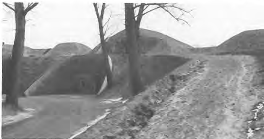
Het bastion Oranje te Naarden in maart 1987, kort na de voltooiing van de restauratie. De foto toont het terreplein en de opril naar de emplacementen voor het positiegeschut (foto S. H. Poppema).
