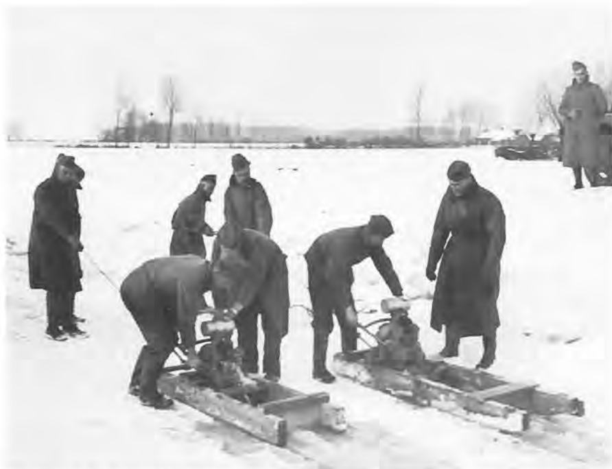
Het kostte in de winter 1939-40 veel inspanning om het Defensiekanaal (gedeeltelijk) open te houden. Met behulp van organieke motorzagen op geïmproviseerde sleden werden stroken ijsvrij gemaakt (foto 6e Compagnie Pioniers).
