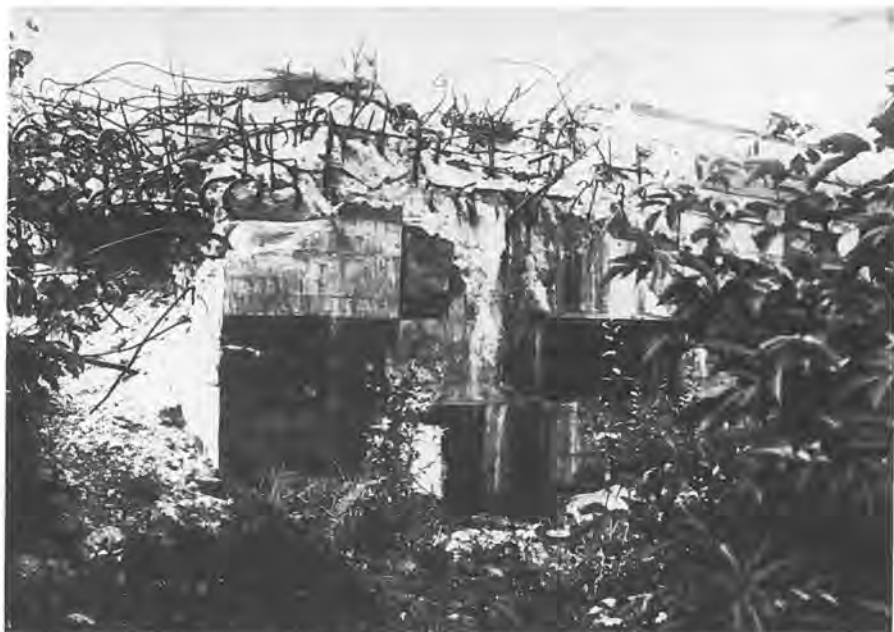
De brugkazemat Zuid naast het westelijk landhoofd van de spoorbrug Mook-Katwijk, kort na het gevecht op 10 mei 1940. Hier sneuvelden zes man politietroepen; twee werden gewond (verzameling Wilson, SMG).
