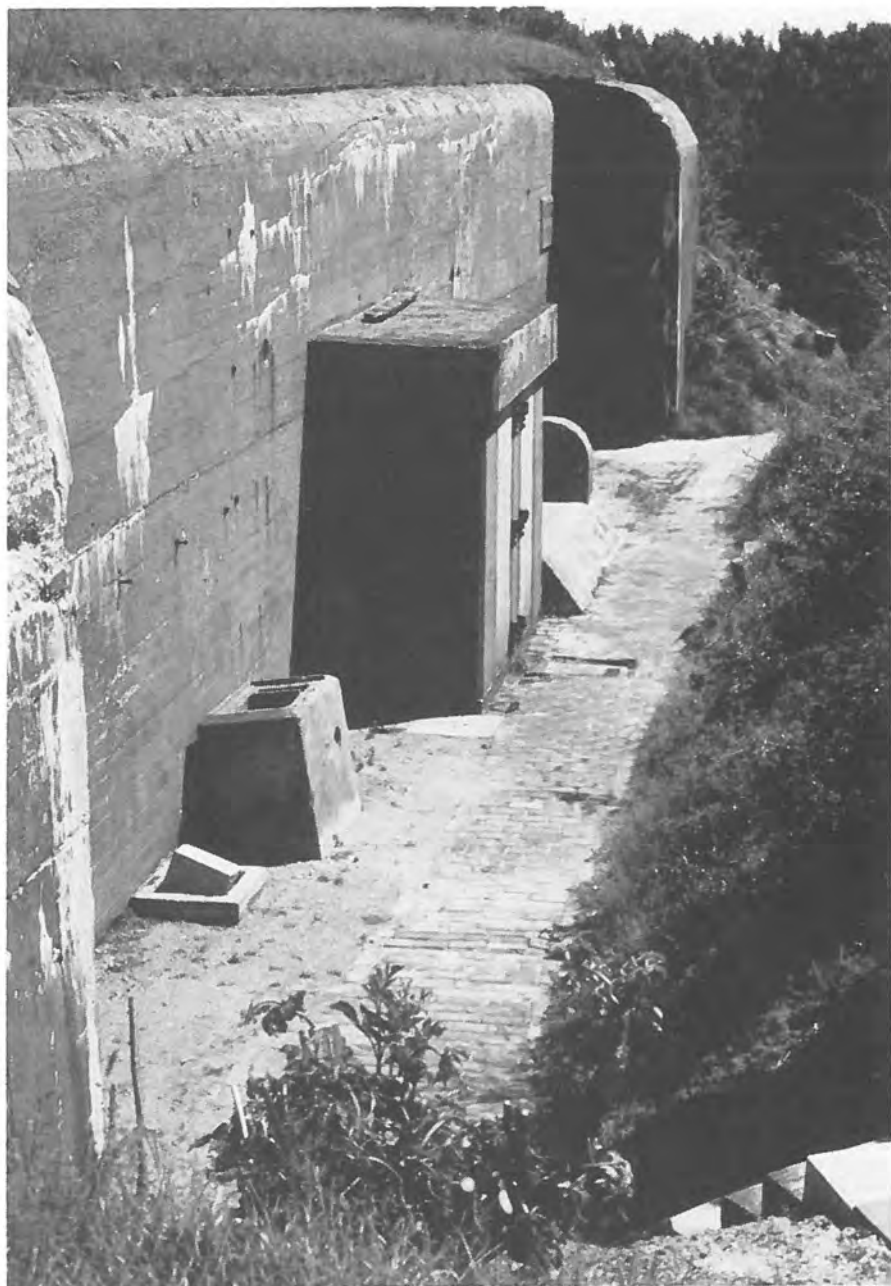
De achterzijde van een van de kazematten, situatie in 1987 (foto G. J. L. Koolhof).
