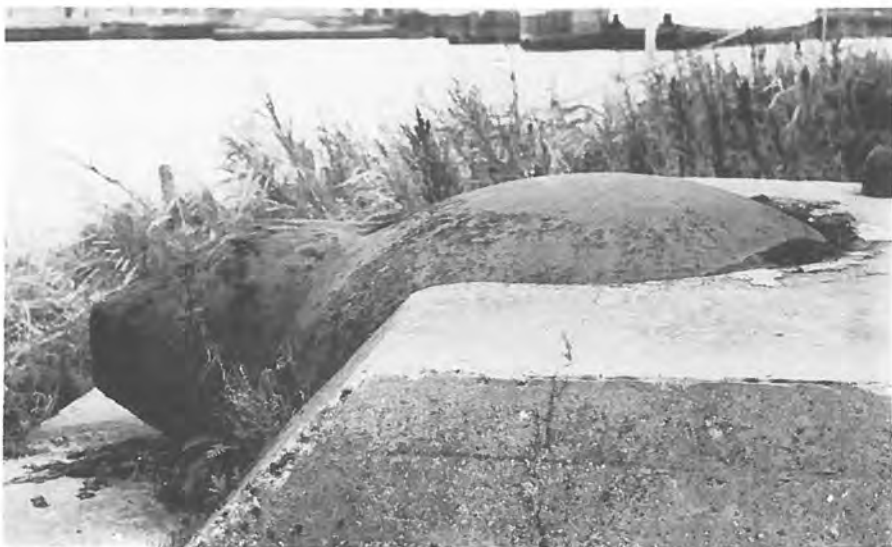
Nederlandse kazemat met gietstalen pantserkoepel (foto G. J. L. Koolhof).
