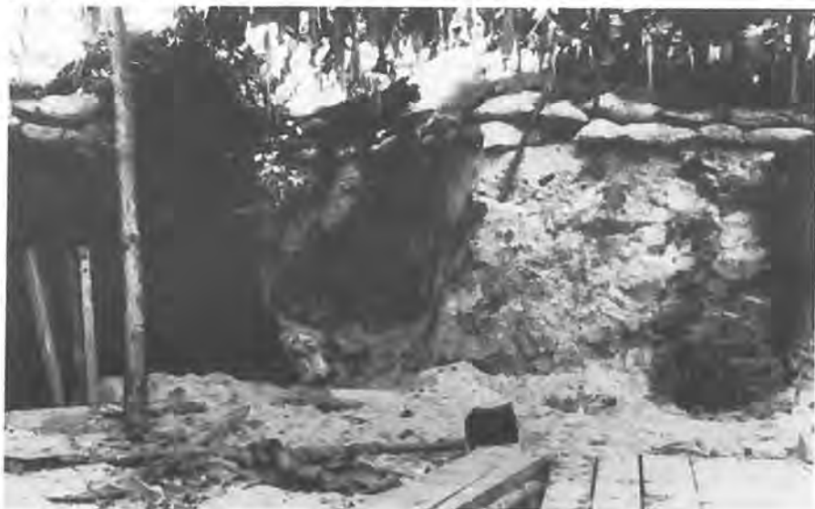
Verlaten gecamoufleerde opstelling voor houwitser 12 lang staal; zie de beddingplanken (foto SMG).
