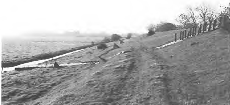
Een uit de jaren 1939-40 daterende tankhindernis in de vorm van een aspergeversperring op de Oostzeedijk (landzijde) bij Muiden. De asperges zijn voor een deel verwijderd met snijbranders; op de kruin en het dijktafud aan de zeezijde is de versperring nog vrijwel compleet aanwezig (foto H. P. G. de Boer).
