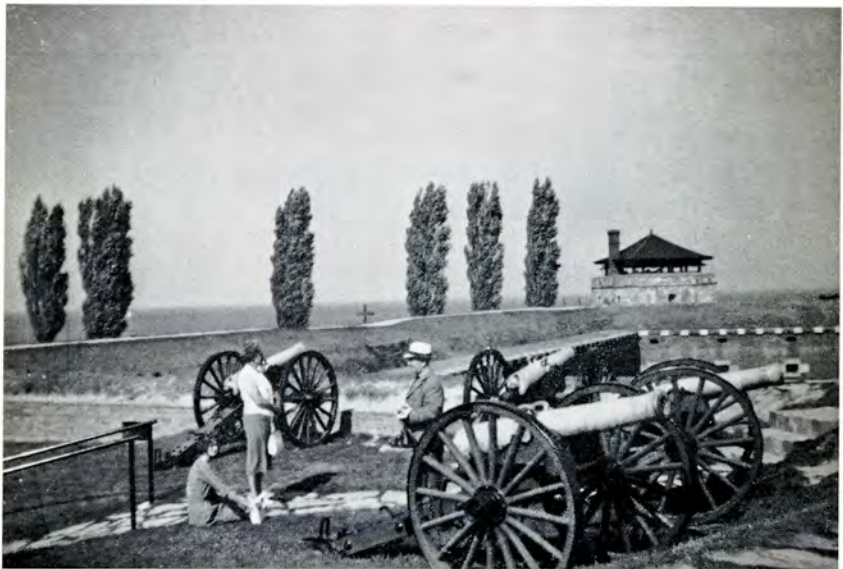
(b) Fort Niagara bij Youngston. (c. 1760) Gezicht op de bastionflank met kazematten en blokhuis in de keel
