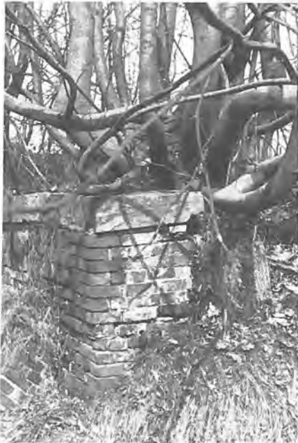
Wildgroei op de gronddekking van het reduit Fort V te Edigem; foto's links en linksboven. De gevolgen daarvan, hetgeen uit de bevroren lekkage uit de muur van de binnencour blijkt; foto rechtsboven. (Foto's H. A. Treu)
