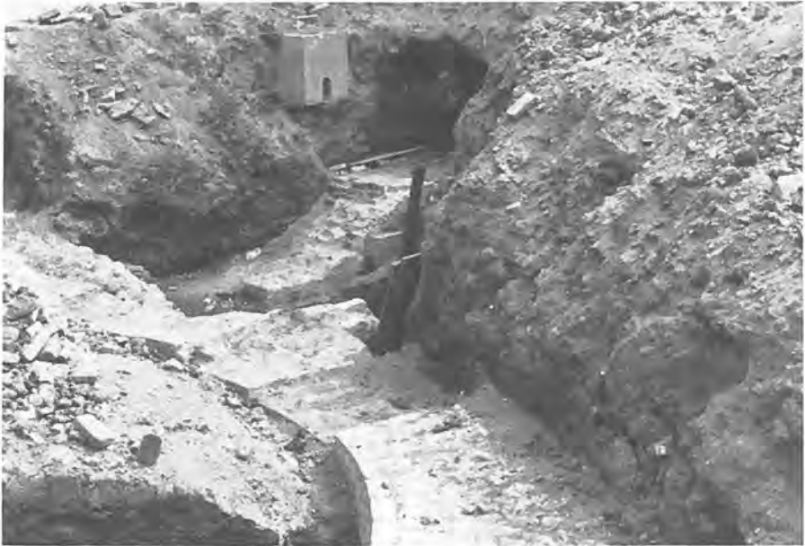
Enkhuizen, opengelegde torenfundering, 1984. (Foto W. F. K. Engelbrecht)
