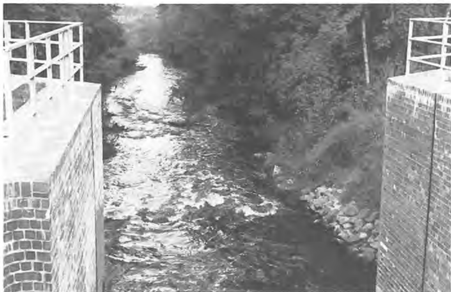
De 'vernieuwde' sluis te Rheinberg. (Foto H. C. Tesink)
