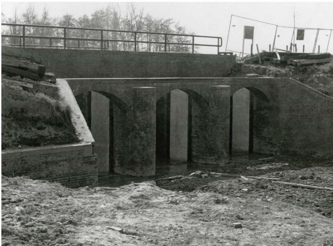
Inlaatwerk van de Beemster, wordt momenteel gerestaureerd met behulp van EU subsidie gelden.
