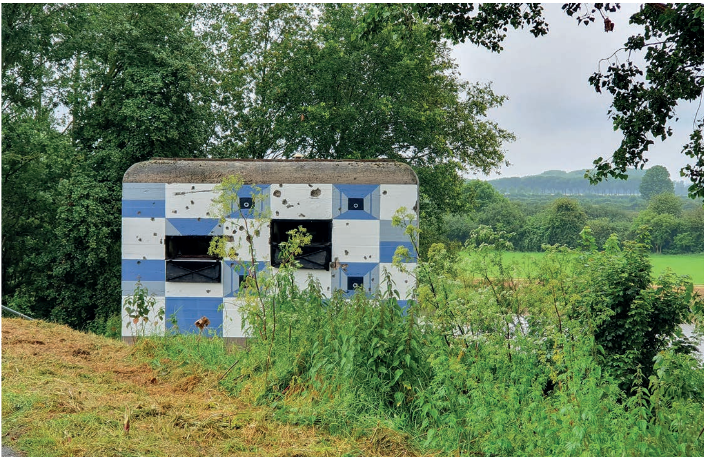
Foto: Raphaël Smid. Nederlandse brugkazemat bij de brug bij Grave.
