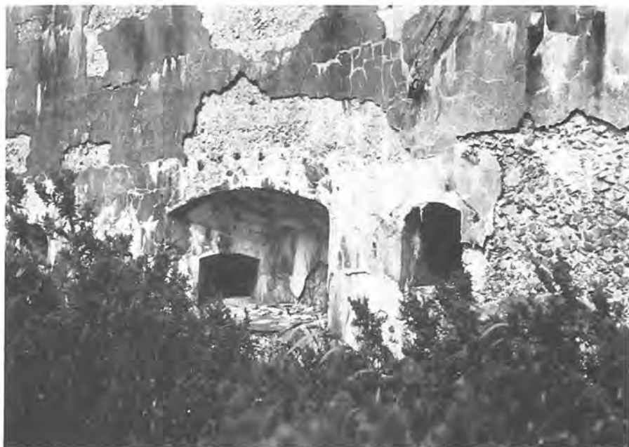
FORT PAMPUS – een vierde koffer temidden van afvallend pleisterwerk en tevoorschijn komend steenbeton in de contrescarp-muur. .
