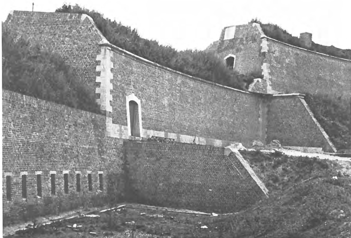
Voltooide restauratie eerste fase van het herstel der Hoge Fronten, Maastricht.
