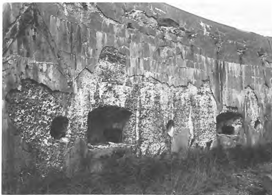
FORT PAMPUS – De contrescarp-muur gezien uit de droge gracht; twee koffers terzijde waarvan de ronde rookgaten. (foto's van de auteur)
