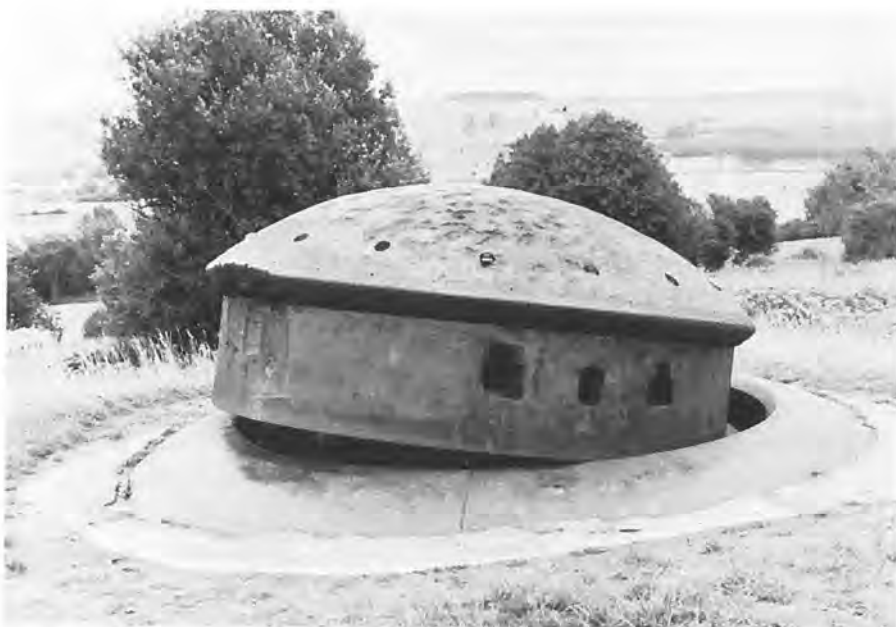
La Ferté. Kanonkoepel, voor 2 25 mm-stukken, omhooggesprongen door Duitse springladingen (foto G. Gerrits).
