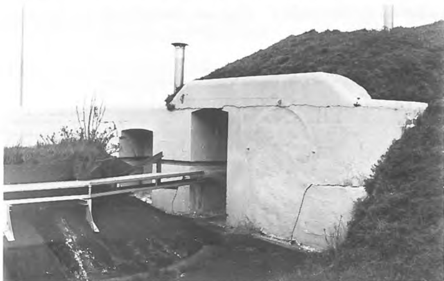
Hetzelfde emplacement tijdens de Eerste Wereldoorlog en in 1977. In de rechtse nis kwam de lopende band voor de munitie uit. Het gangetje voor het personeel is dichtgemetseld.
