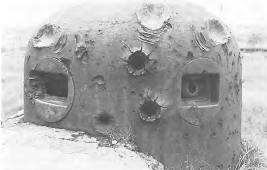
La Ferté. Mitrailleurklok, beschoten door Duits 88 mm-geschut.
