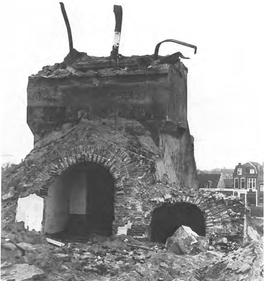
Een holtraverse tijdens de sloop. Links de ruimte in de traverse, rechts de trap die naar de kazerne leidt. Er bovenop een betonnen uitkijkpost.
