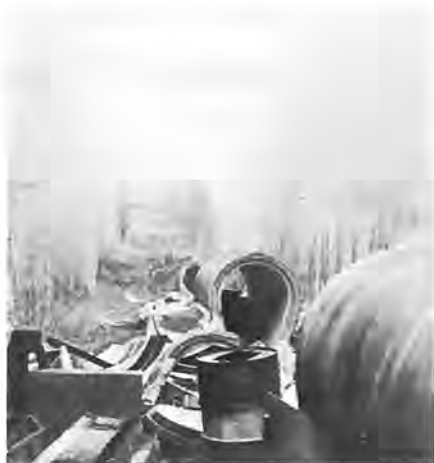
Afb. 4 In de met stortmateriaal gevulde silo's had men gangen gemaakt van rioolbuizen, zoals er op de foto nog enige voorkomen (tussen schroot van heden). Hierdoor kruipende kon men bij de springladingen komen.
