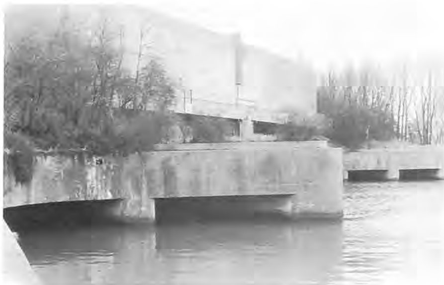
Afb. 5 Inundatie-riolen in de Plofsluis.
