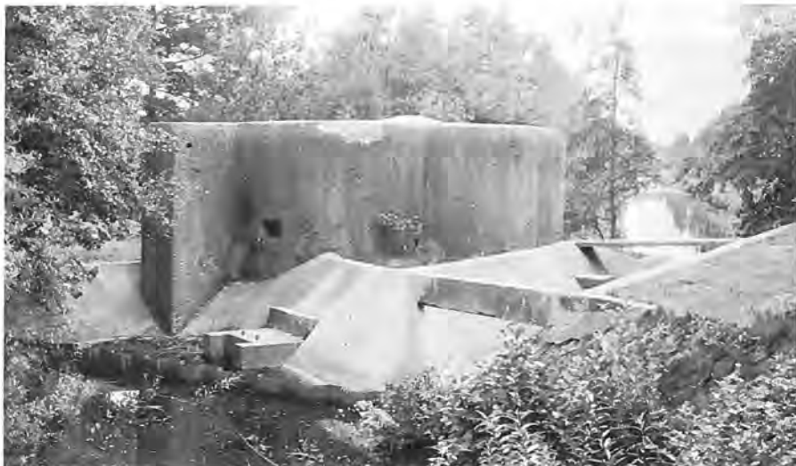
Een sluisbunker in het anti-tankkanaal.
