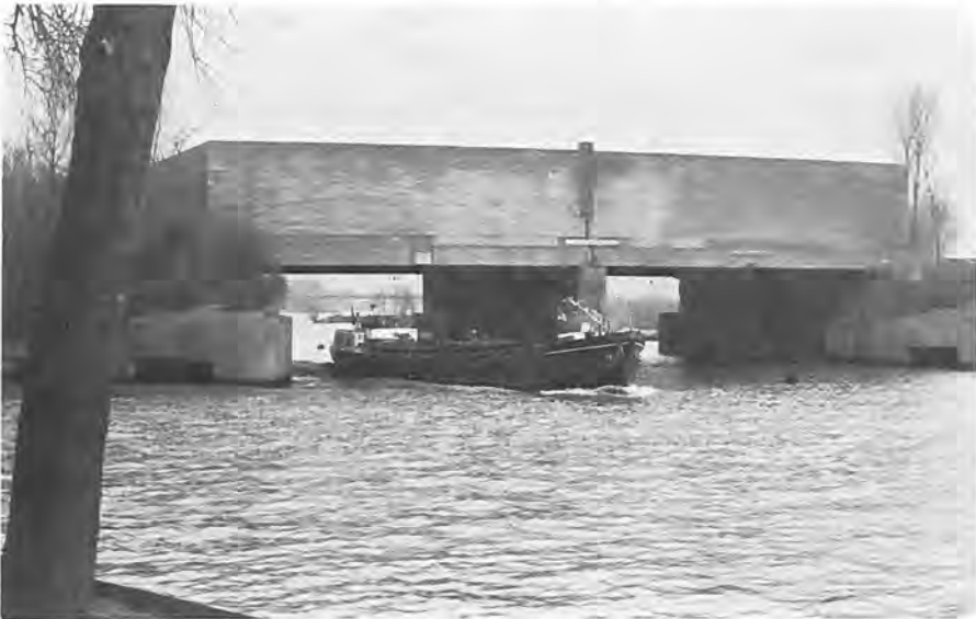
Afb. 2 De 'Plofsluis', in wezen een inundatiesluiswerk met een enorme betonnen zandbak (verdeeld in 5 compartimenten 'silo's') daarover heen gebouwd. De bodem van de bak – tevens plafond van de doorvaartopeningen – kon worden opgeblazen, om het stortmateriaal uit te storten.
