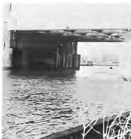
Afb. 3 In het 'plafond' van de doorvaart ziet men de gewelven van ongewapend beton. Door het doen springen van de bodems der silo's zou met het vrijkomende stortmateriaal het kanaal in een oogwenk worden afgedamd.
