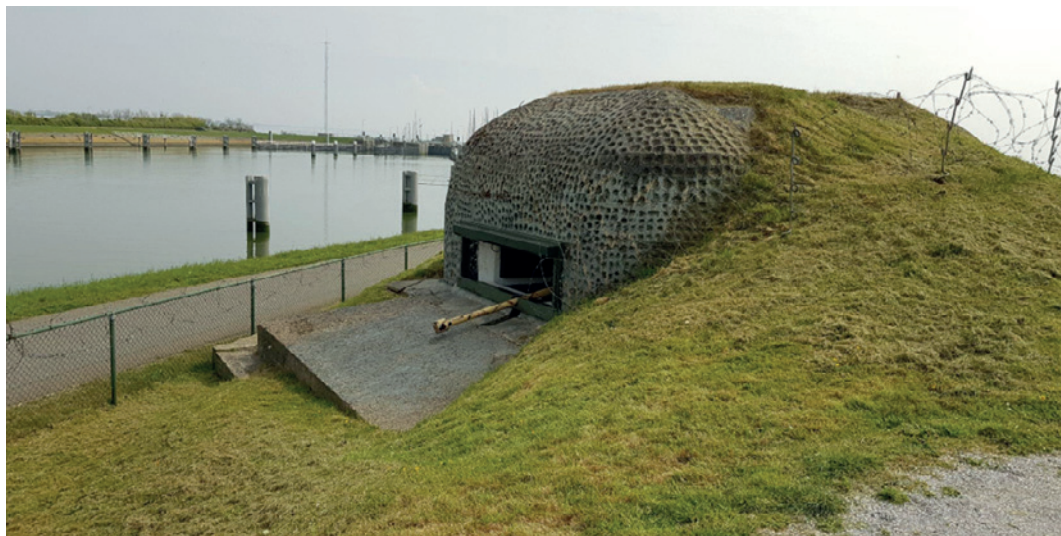
De Duitse kanonbunker met een 5cm KwK (Kampfwagenkanone) naast de IV vandaag de dag. De funderingsplaat van stampbeton is goed te zien. Foto T. Buruma
