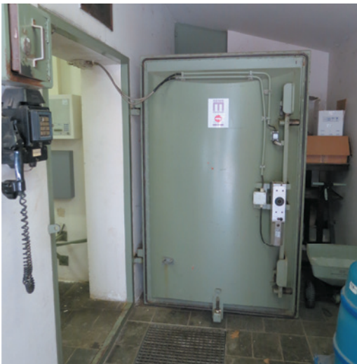
Vught, deur in verbindingbunker, voor nadere verklaring, zie de foto op bladzijde 4 (foto Dik Winkelman)
