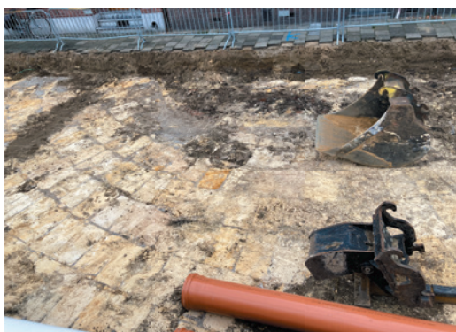
Maastricht, Gezicht op de rioleringswerkzaamheden in november 2022. Delen van de contouren van de Bolwerkpoort kwamen duidelijk in het zicht. (foto Jos Notermans)
