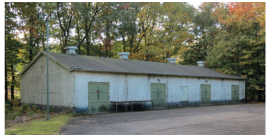
Best, loods van het MOB-complex aan de Sonseweg. Op dit complex bevindt zich tegenwoordig het Museum Bevrijdende Vleugels. (foto Dik Winkelman)
