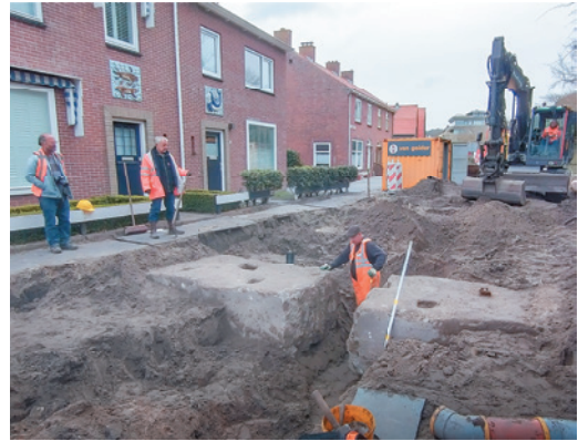
Zoutelande, Steckträgersperre
