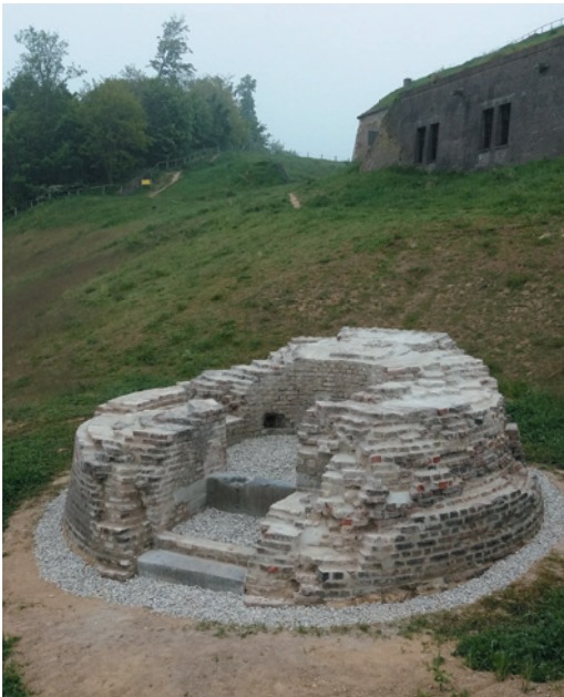
Maastricht, de waterput buiten het Fort Sint Pieter na afronding van de werkzaamheden
