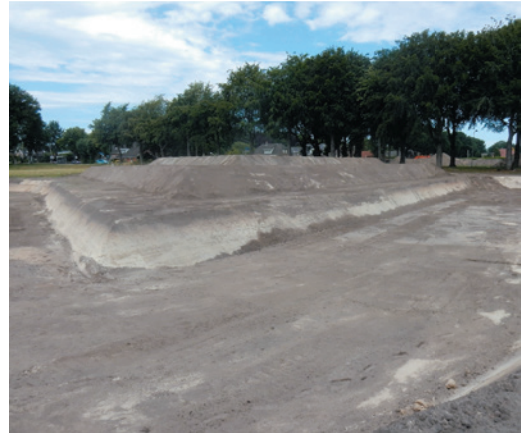
De reconstructie van de wallen en het heropenen van de gracht (foto Hans van Westing)
