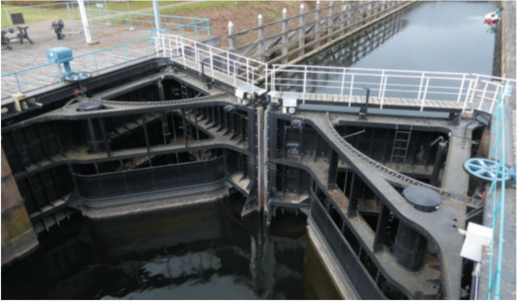
Zuidelijke waaiersluisdeuren in Afgedamde Andelse Maas. De schuine aarden wanden van de sluiskolk zijn zichtbaar. (foto Ad Littel)
