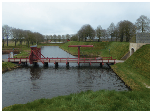
Westelijke toegangbrug (Foto: Ad Littel)
