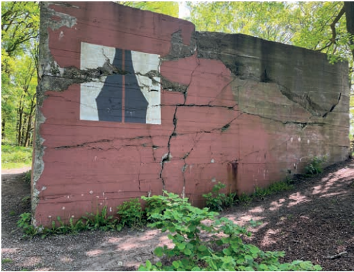
Gerestaureerde Duitse bunker van de Pantherstellung, buitenzijde
