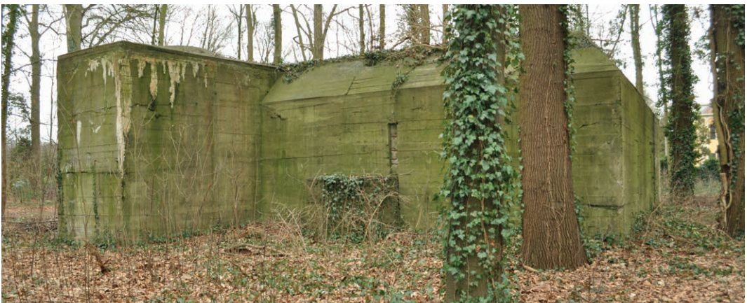
Een van de twee commandobunkers die begin 1945 zijn gebouwd ten oosten van de IJssel. Het gaat hierbij om het zeldzame type 621 n.A. Dit exemplaar heeft de vleugelmuur met open observatiepost.
