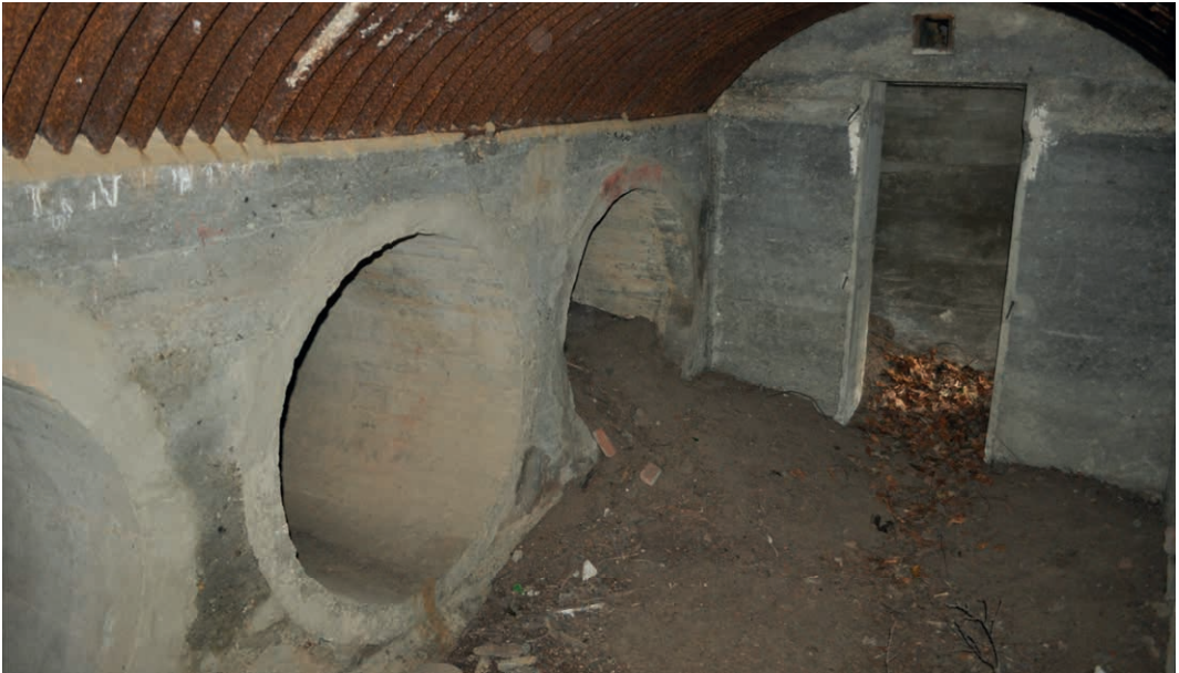
Een van de twee identieke bouwwerken die bestaan uit zes 'Kochrohren' en vermoedelijk werden gebruikt als schuïlbunker. Beide bunkers zijn niet toegankelijk, ze liggen op privé terrein.
