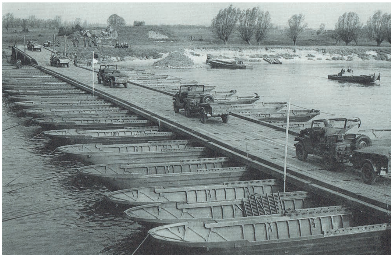
Foto uit 250jr Genietroepen - M4-brug klasse 35 met oefening Citra Ultra bij Gorssel 1958
