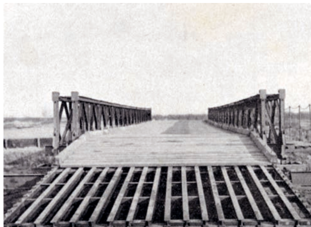
Via auteur – Baileybrug gereed voor gebruik
